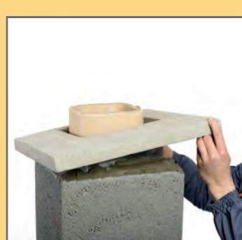
26. Osadzić betonową płytę przykrywającą na zaprawie.
