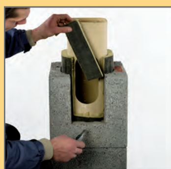
4. Dociąć płytę z wełny mineralnej do rozmiarów otworu w pustaku.
