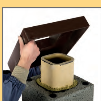
22. Założyć przykrywającą płytę włóknowo-cementową.
