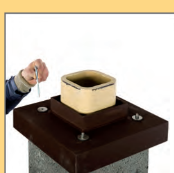
23. Wkręcić śruby, założyc podkładki gumowe i metalowe, przykręcić nakrętkami kołpakowymi.
