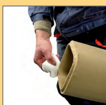
10. Oczyszczyć pióro-wpust wilgotną gąbką.
