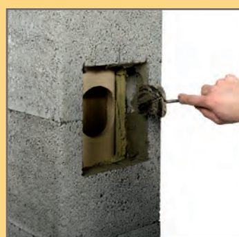
17. Na ścianki przygotowanego otworu nałożyć zaprawę
