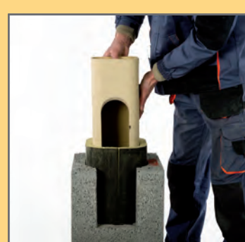
3. Na zaprawie murarskiej ustawić wyczystkę ceramiczną.
