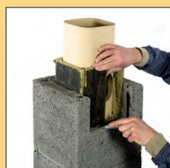
15. Dociąć wełnę do przygotowanego otworu.
