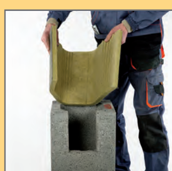
2. Osadzić pustak z wyciętym otworem na drzwiczki (16x31 cm) na cokole, umieścić płytę z wełny mineralnej.
