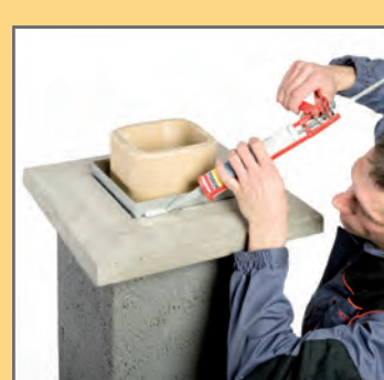
27. Prześnić między kołnierzem szalunku a płytą uszczelnić silikonem dekarskim
