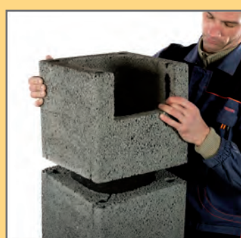
13. Pustak z wyciętym otworem na przyłącze spalin osadzić na zaprawie.
