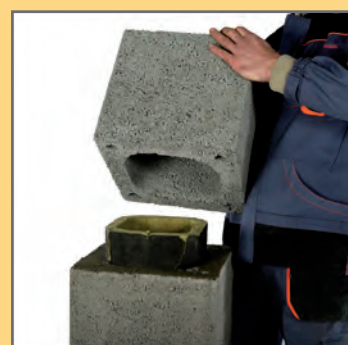
9. Osadzić następny pustak na zaprawie.
