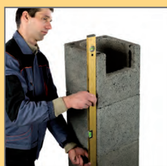
14. Dokładnie sprawdzać poziom kominu.
