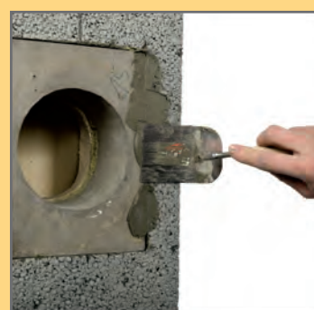
18 ... i osadzić w nim betonową kształtkę przyłączeniową.
