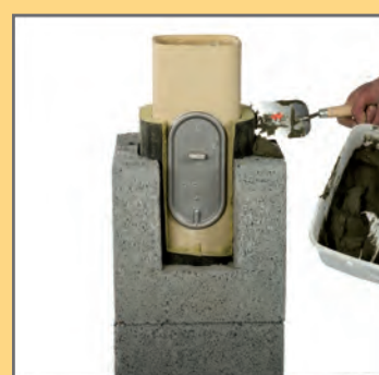
6. Nałożyć zaprawę murarską na pustak.
