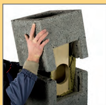
16. Osadzić pustak na zaprawie z kolejną częścią wycięcia.
