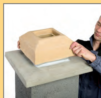
30. Przykleić ceramiczną osłonę wylotu kominu.
