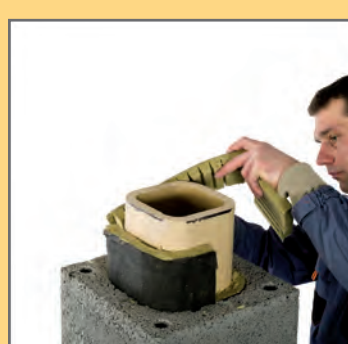
19. Obciąć nadmiar wełny za ostatnim pustakiem.
