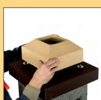
24. Nałożyć kit na uciętą rurę i przykleić ceramiczną osłonę wylotu kominu.
