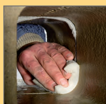
12. Usunąć nadmiar kitu z wewnętrznej strony fugi przy pomocy wilgotnej gąbki.
