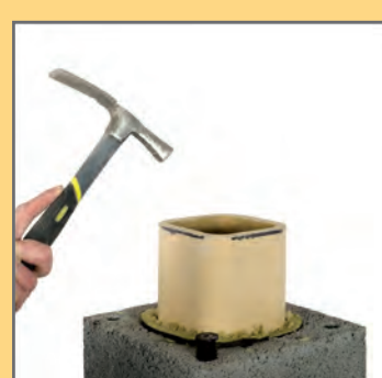
21. Wbić kołki montażowe w narożne otwory pustaka.
