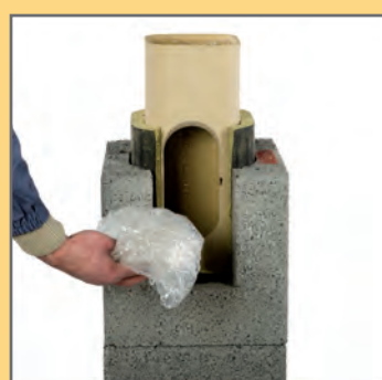
5. Do środka wyczystki włożyć kawałek folii lub papieru w celu ochrony przed spadającą zaprawą.
