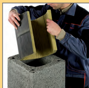
8. Wsunąć wełnę mineralną do kolejnego pustaka.
