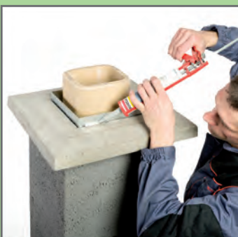
33. Uszczelnić silikonem przestrzeń między kołnierzem szalunku a płytą
