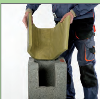
7. Umieścić płytę z wełny mineralnej.
