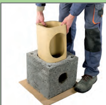
1. Na izolacji poziomej, pokrytej warstwą zaprawy murarskiej, ustawić pustak z wyciętym otworem i rurę cokołową.
