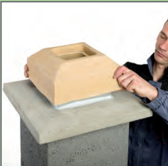
36. Przykleić ceramiczną osłonę wylotu kominu.
