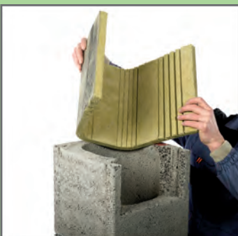
20. Umieścić płytę z wełny mineralnej.
