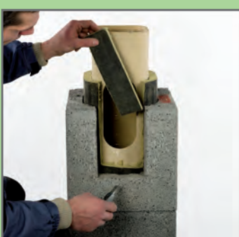
10. Dociąć płytę z wełny mineralnej do rozmiarów otworu w pustaku.
