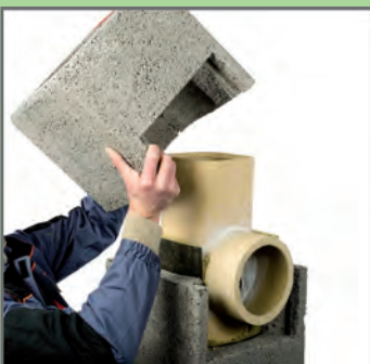
23. Osadzić pustak z dalszą częścią wycięcia na zaprawie.
