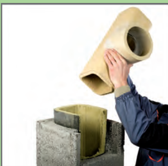
22. Wkleić trójknik (podłączenie pieca).
