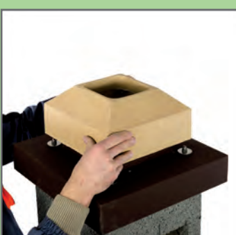
30. Nałożyć kit na uciętą rurę i przykleić ceramiczną osłonę wylotu kominu.
