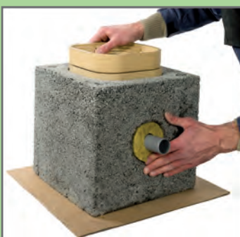
4. Połączyć miskę odpływu kondensatu i rurę cokołową.
