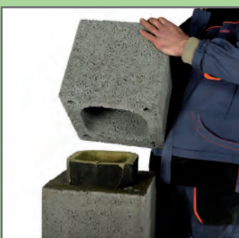
15. Osadzić następny pustak na zaprawie.
