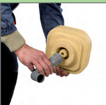
2. Podłączyć odpływ (rura PCV) z miską.
