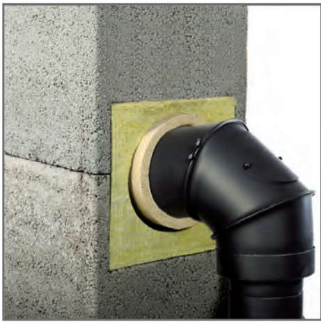
Przykład prawidłowego podłączenia z zastosowaniem redukcji. Podłączenie prowizoryczne należy wykonywać w ten sam sposób. Nieprawidłowe podłączenie może doprowadzić do awarii.
