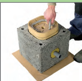
5. Nałożyć kit kwasoodporny na miskę odpływu kondensatu.
