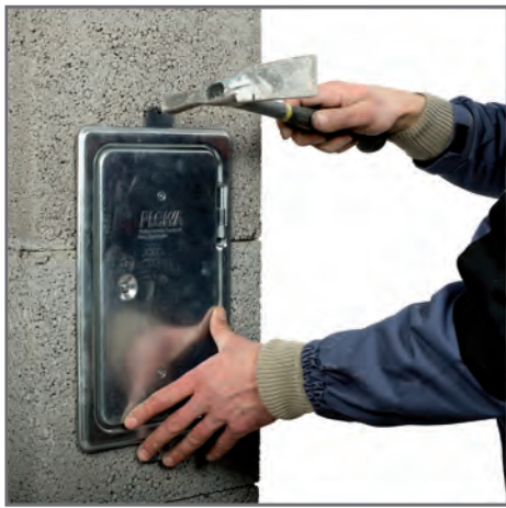
Zewnętrzne drzwiczki czyszczaka mocujemy za pomocą gwoździ papiazków i obrabiamy zaprawą tynkarską.
