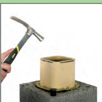
27. Wbić kołki montażowe w narożne otwory pustaka.
