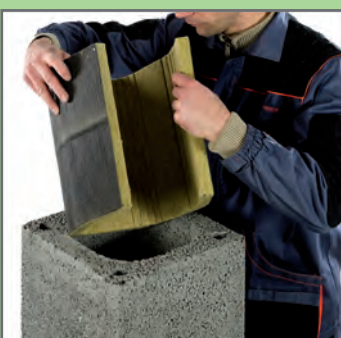
14. Wsunąć wełnę mineralną do kolejnego pustaka.
