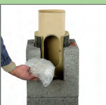
11. Do środka wyczystki włożyć kawałek folii lub papieru w celu ochrony przed spadającą zaprawą.
