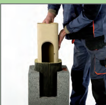
9. Umieścić wyczystkę w misce odpływu kondensatu, usunąć nadmiar kitu z wewnętrznej strony rury.
