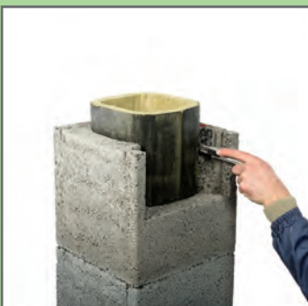
21. Dociąć wełnę do przygotowanego otworu.
