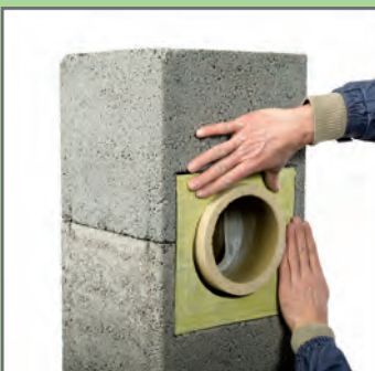
24. W wyciętym pustaku zamontować płytę z wełny mineralnej.
