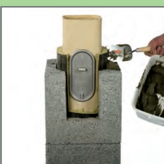
12. Nałożyć zaprawę murarską na pustak.
