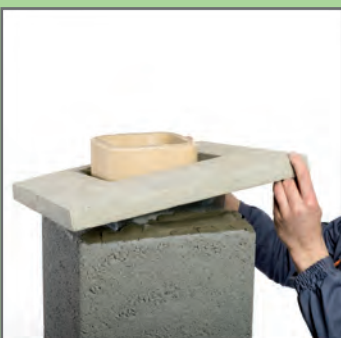
32. Osadzić na zaprawie betonową płytę przykrywającą.
