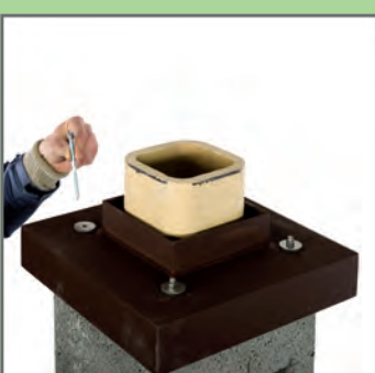
29. Wkręcić śruby, założyć podkładki gumowe i metalowe, przykręcić nakrętkami kołpakowymi.
