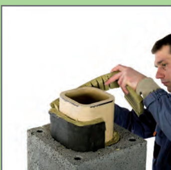
25. Obciąć nadmiar wełny za ostatnim pustakiem.
