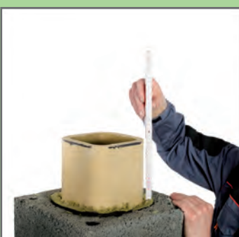
26. Odmierzyć żadaną długość rury tak, aby ceramiczna osłona wylotu kominu znalazła się 1 cm powyżej płyty przykrywającej.
