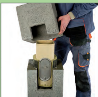
13. Pustak z dalszą częścią wycięcia osadzić na zaprawie.
