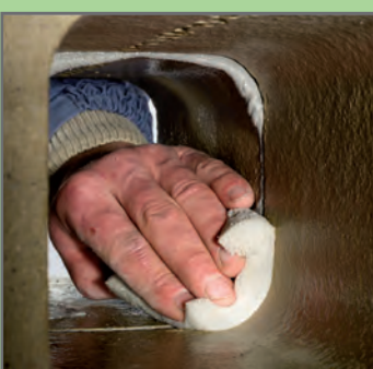
17. Usunąć nadmiar kitu z wewnętrznej strony fugi przy pomocy wilgotnej gąbki.
