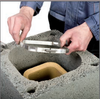
10. Zamontować na wyczystce opaskę z odstępnikami.
