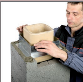
29. Zamocować szalunek tracony na zaprawę.
