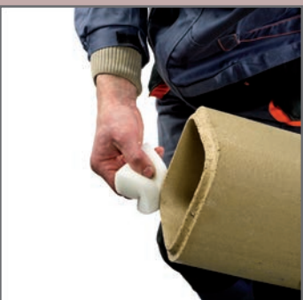
7. Oczyszczyć pióro-wpust wilgotną gąbką.
