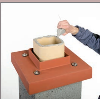
26. Przykręcić płytę włóknowo-cementową przy pomocy dołączonego zestawu mocującego. Nałożyć kit na uciętą rurę.
