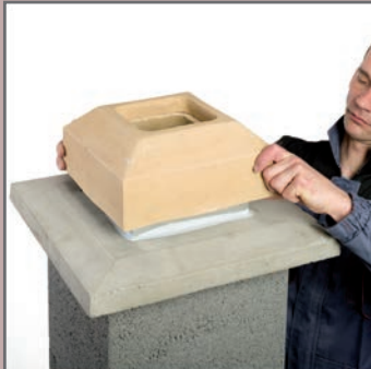
33. Przykleić ceramiczną osłonę wylotu komin a.
