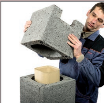
20. Pustak z wyciętym otworem na przyłącze spalin osadzić na zaprawie.
