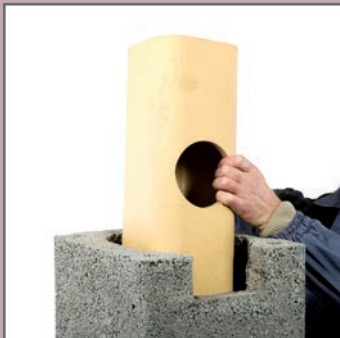
21. Wkleić podłączenie pieca.
