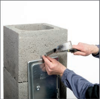
13. Przymocować zewnętrzne drzwiczki wyczystki gwoździami (papiakami).
