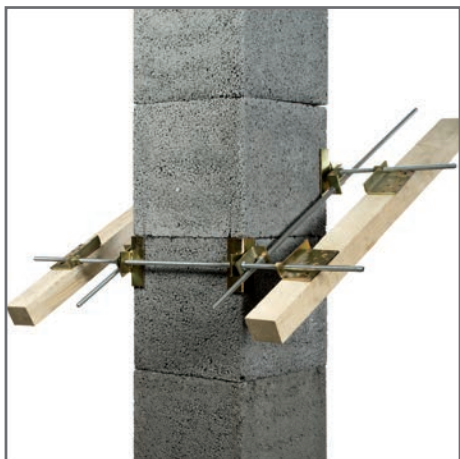
Usztywnienie kominu w miejscu przejścia przez dach.
