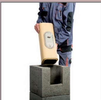
8. Umieścić wyczystkę w misce odpływu kondensatu, usunąć nadmiar kitu z wewnętrznej strony rury.
