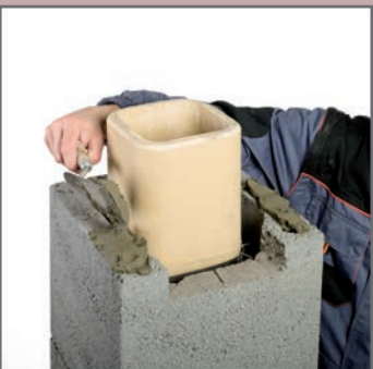
28. Nałożyć zaprawę na pustak z wyciętymi otworami. Szczeliny lub otwory doprowadzające powietrze do pieca muszą mieć powierzchnię 1,5 x większą niż powierzchnia przekroju rury odprowadzającej spaliny.
