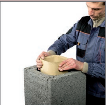
19. Docisnąć rurę aby wycisnąć nadmiar kitu, usunąć go wilgotną gąbką.
