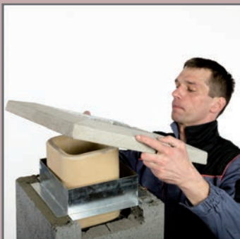
30. Osadzić betonową płytę przykrywającą.
