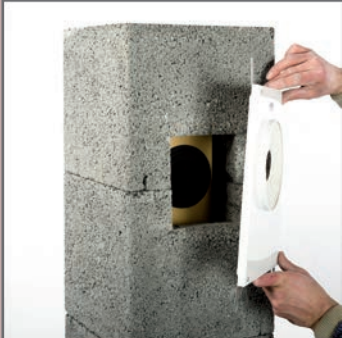
23. Wycentrować blendę z podłączeniem w ceramice.
