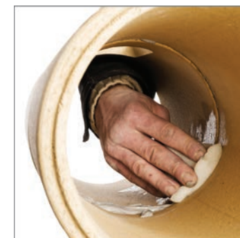
8. Nadmiar kitu usunąć wilgotną gąbką.
