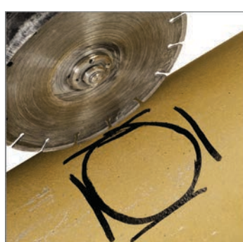
3. Szlifierką kątową wyciąć odrysowany otwór.
