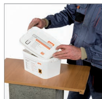
1. Kit kwasoodporny należy rozrabiać w małych porcjach. Po około 60 min. rozpoczyna się proces twardnienia, po tym czasie rozrobionej masy już nie należy używać.
