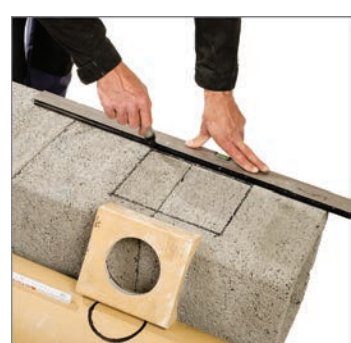
2. Zaznaczyć miejsce wycięcia otworu w pustaku.
