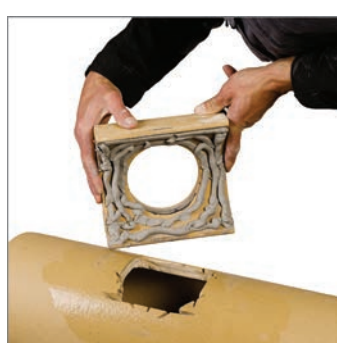
4. Kształtkę ceramiczną oczyścić, nałożyć kit kwasoodporny.
