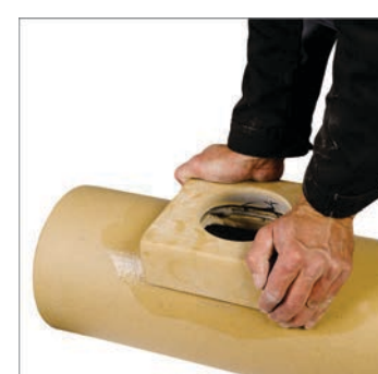
5. Mocno docisnąć kształtkę, pozostawić do wyschnięcia.
