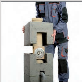
5. Osadzić następny pustak na zaprawie
