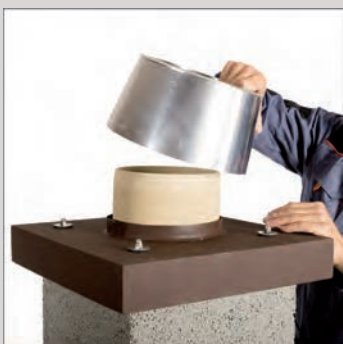
27. Założyć osłonę wylotu komina.
