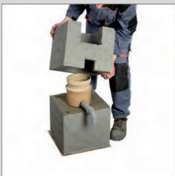
3. Osadzić pustak z wyciętymi otworami na rurkę do odpływu kondensatu i zewnętrzne drzwiczki czyszczaka.
