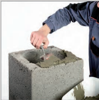
9. Nałożyć zaprawę murarską.
