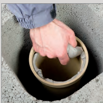
11. Nałożyć kit kwasoodporny na oczyszczony wilgotną gąbką kielich rury ceramicznej.
